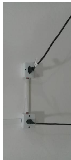
Instalação de tomada na sala da tomografia
