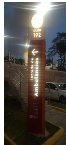
Instalação elétrica do letreiro do SAMU
