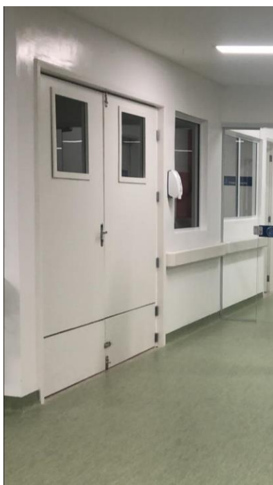
Antes da adequação
