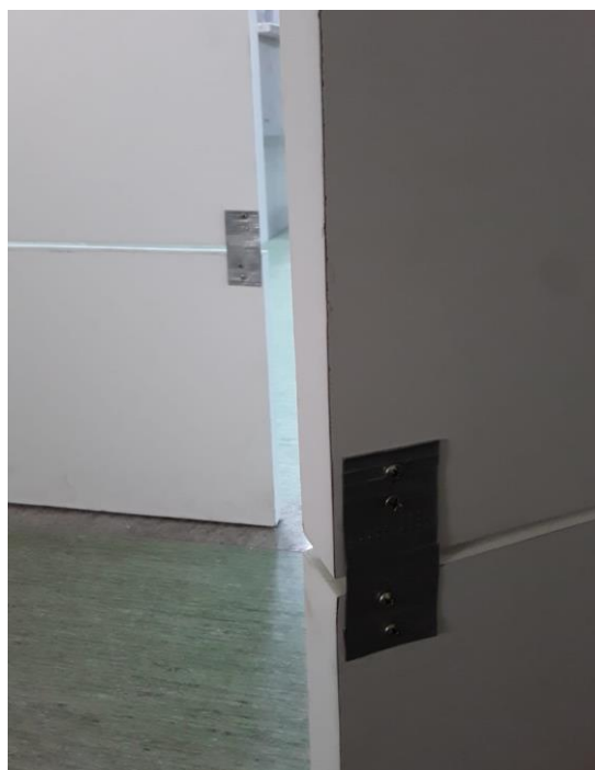
Instalação da chapa de aço
